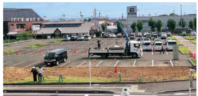
▲工事写真(8月時点)
