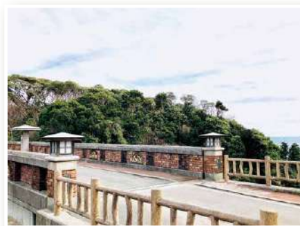
「赤煉瓦の橋」 撮影：はなこさん 場所：新鮎川橋（和地町）
