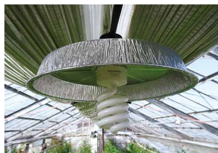
▲写真1 傘設置の様子 （半径28cmのアルミ皿）
